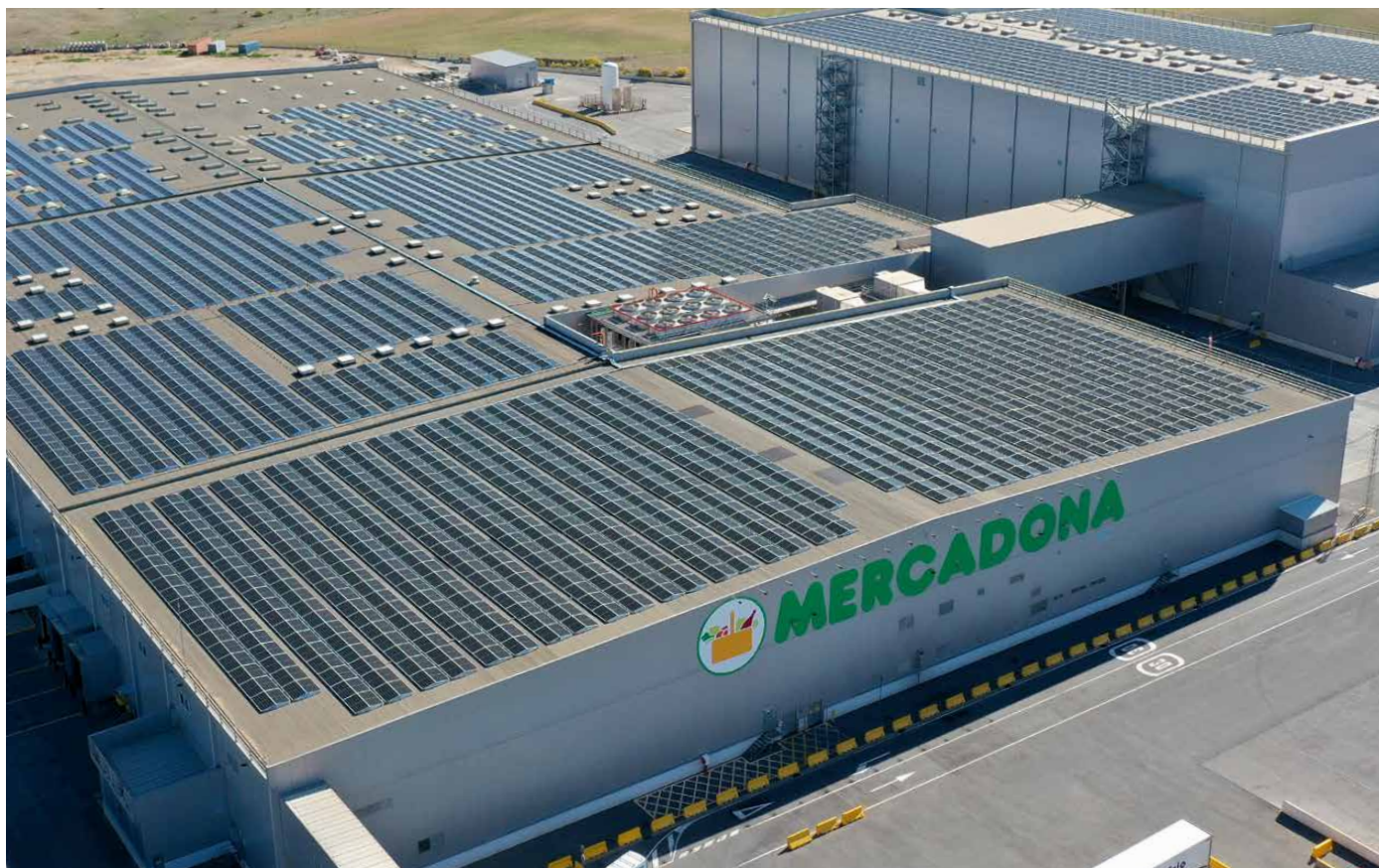
Painéis solares instalados no bloco logístico de Guadix, Granada.
